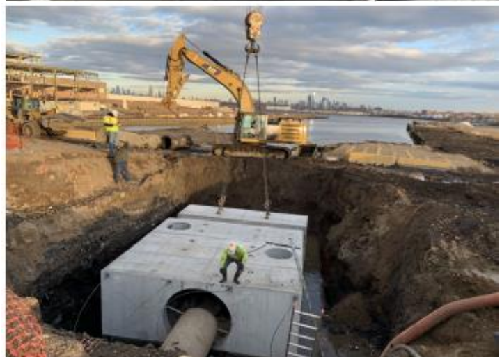
Bóveda inteligente con 3 clases diferentes de Smart Sponge en Kearny Point, New Jersey
